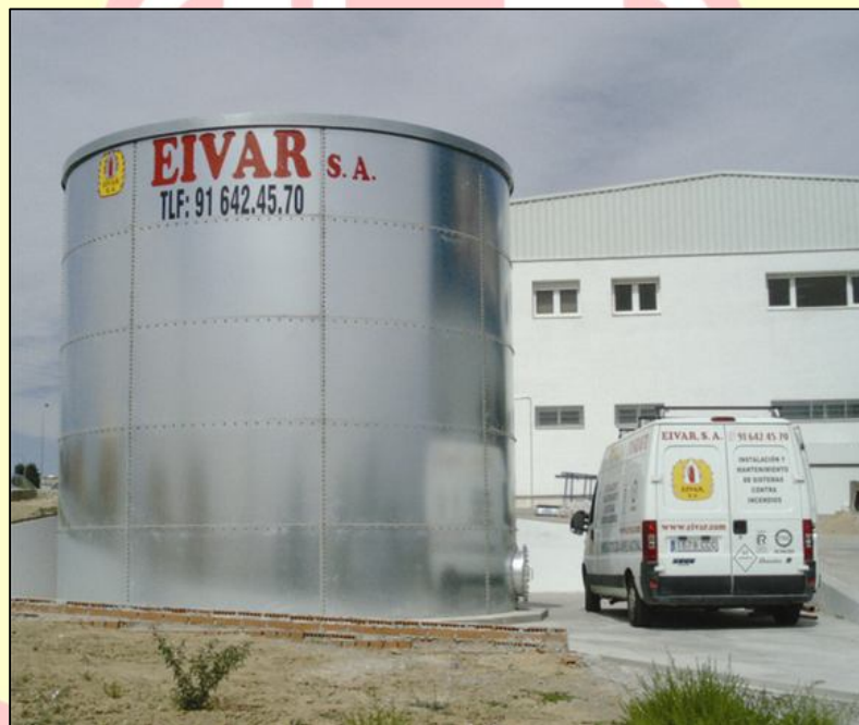
Foto. Aljibe de chapa galvanizada
